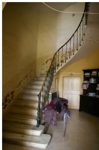
départ de l'escalier intérieur © Jennifer Gomez (2007).
